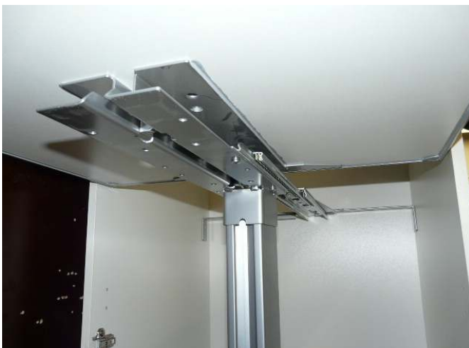
Abb. 3: Obere Führungsschiene am obersten Tablar
