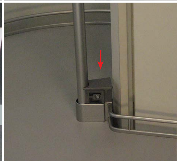
Insertar la bandeja y la clavija de fijación
