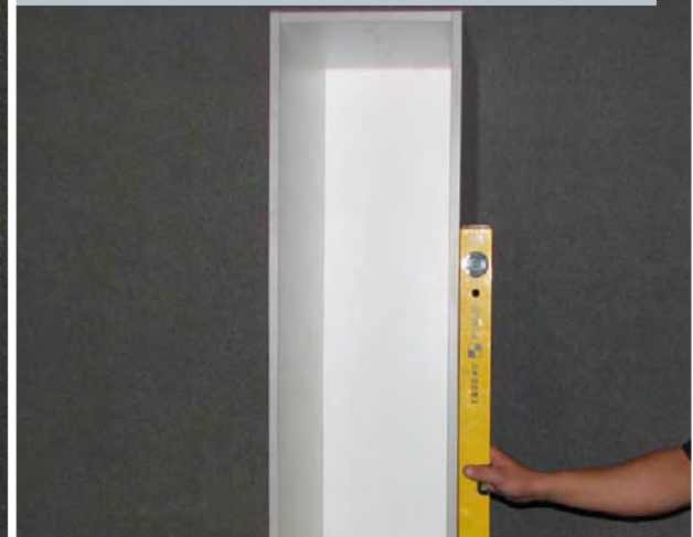
2. Alinear el cuerpo con el nivel de burbuja de aire
